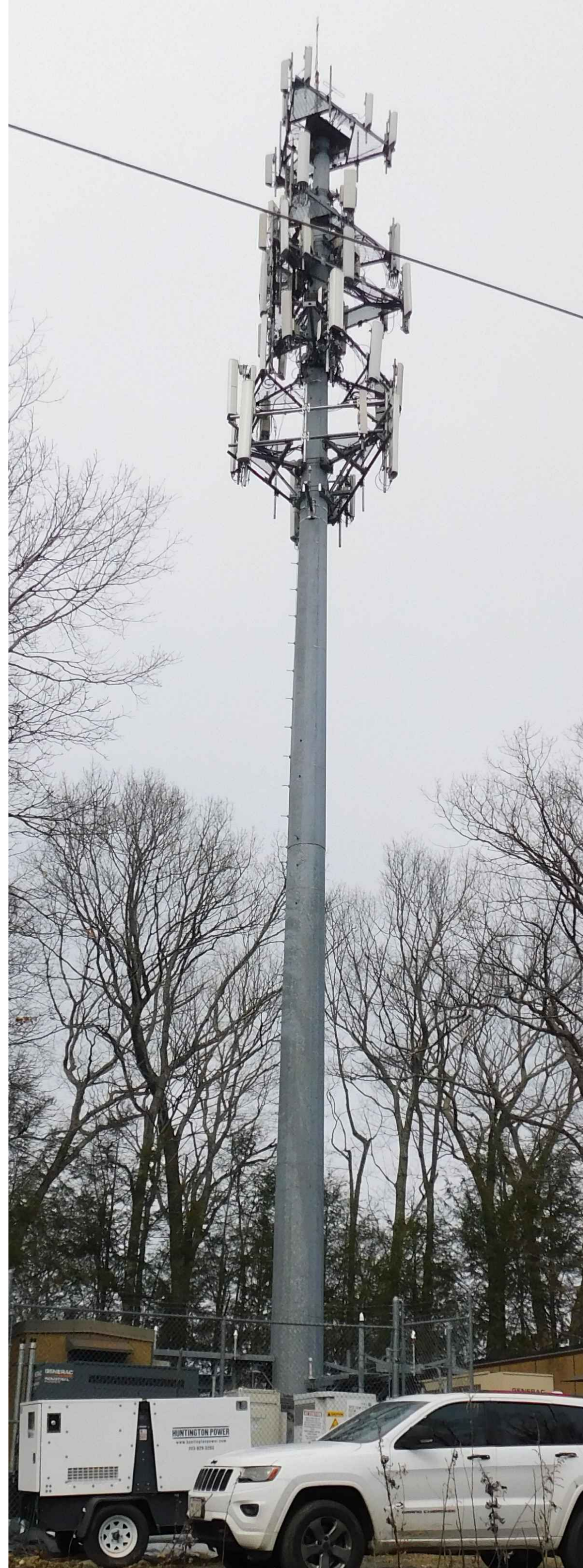
EXISTING TOWER PHOTO (1) SCALE: N.T.S.
