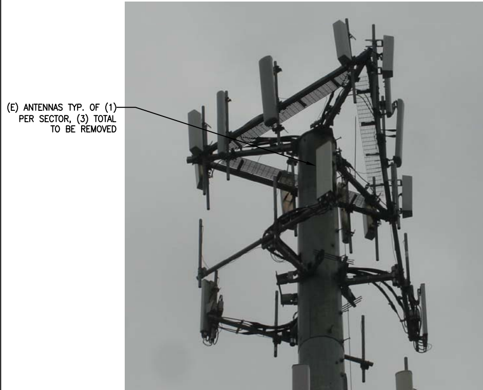
1 A-3 EXISTING ANTENNA MOUNT TYP. N.T.S.
