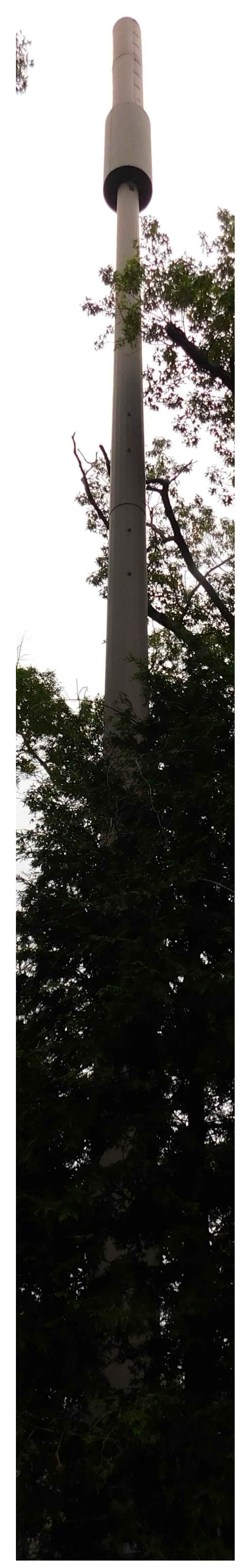
EXISTING TOWER PHOTO SCALE: N.T.S.
