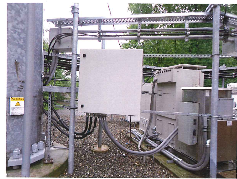
4 EXIST FIBER DISTRIBUTION BOX A-3 SCALE: N.T.S.
