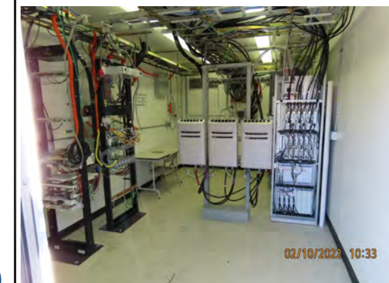
SITE PHOTO 2 SCALE: N.T.S. 3
