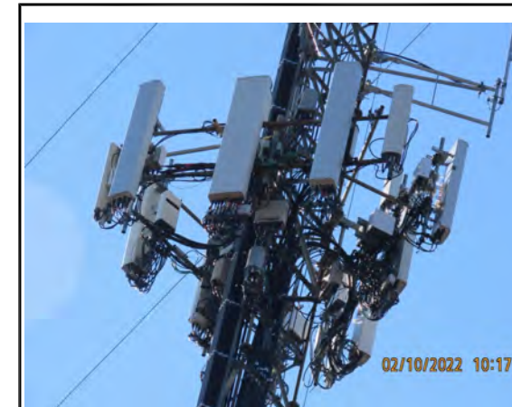
SITE PHOTO 1 SCALE: N.T.S. 2
