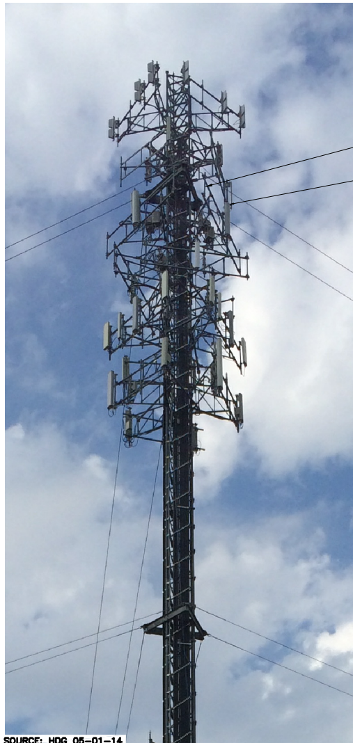
EXISTING PARTIAL ELEVATION PHOTO DETAIL SCALE: N.T.S.
