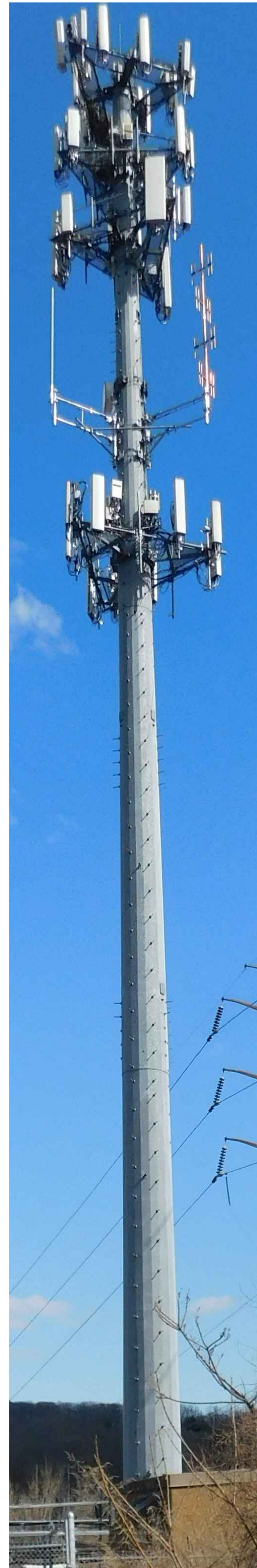
EXISTING TOWER PHOTO SCALE: N.T.S.
