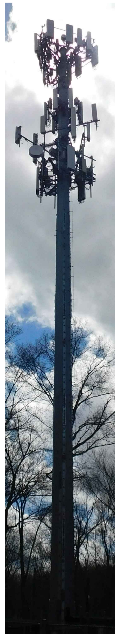
EXISTING TOWER PHOTO 1 N.T.S. A-2
