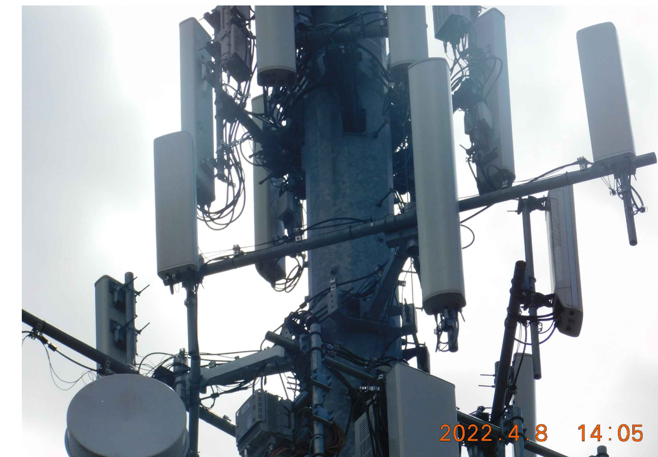
EXISTING ANTENNA PHOTO 3 N.T.S. A-2
