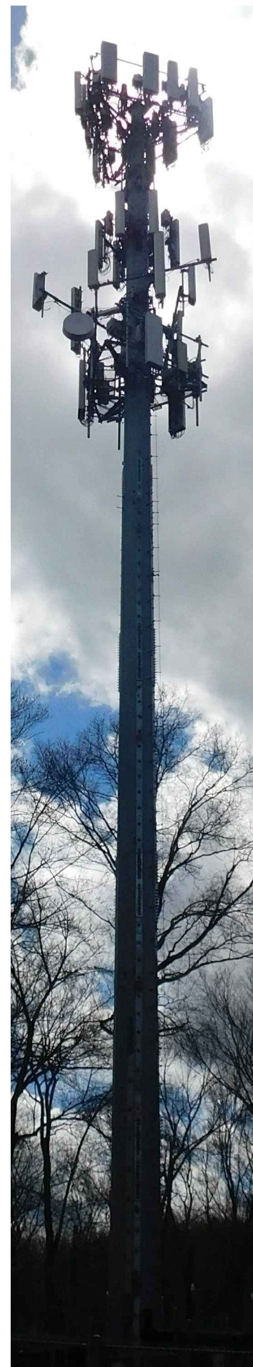
EXISTING TOWER PHOTO 1 N.T.S. A-2
