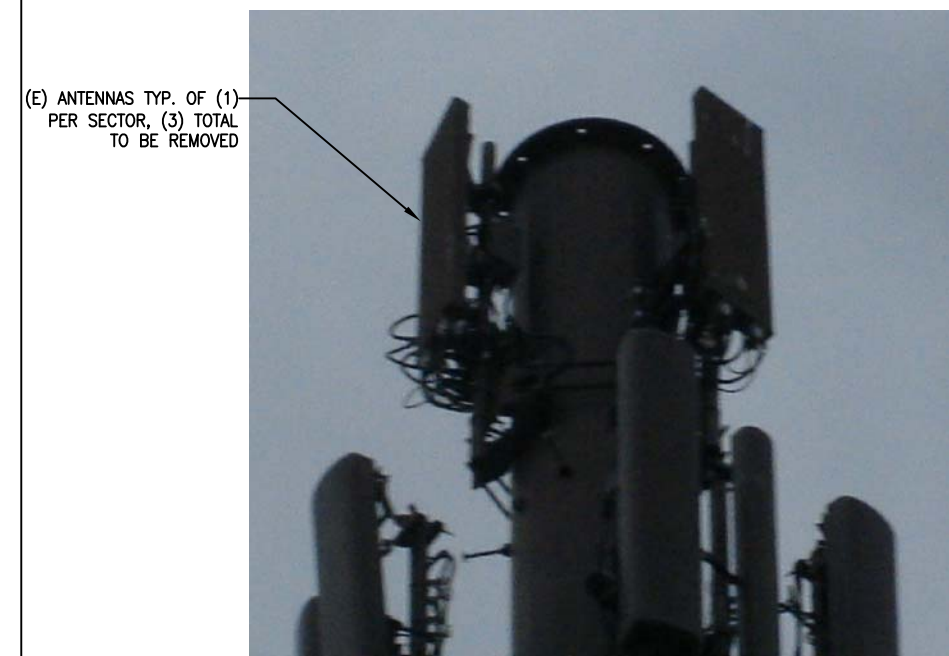
3 EXISTING ANTENNA MOUNT TYP. N.T.S.
