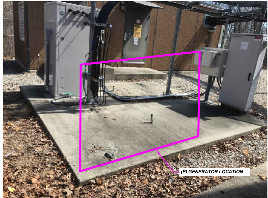
LOCATION PHOTO 3 N.T.S. A-1
