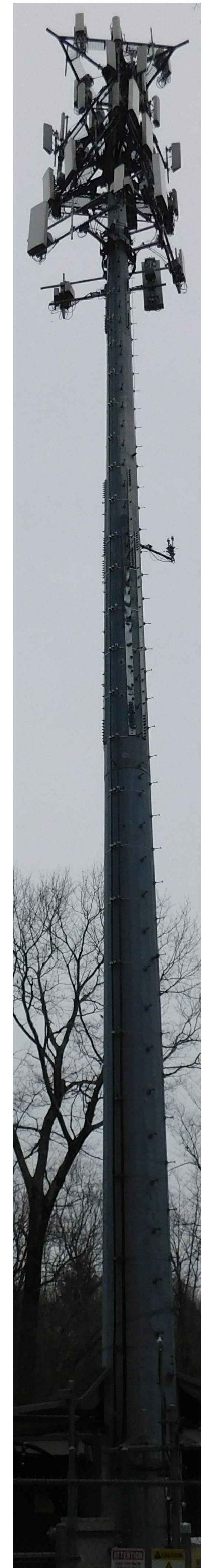
EXISTING TOWER PHOTO SCALE: N.T.S.
