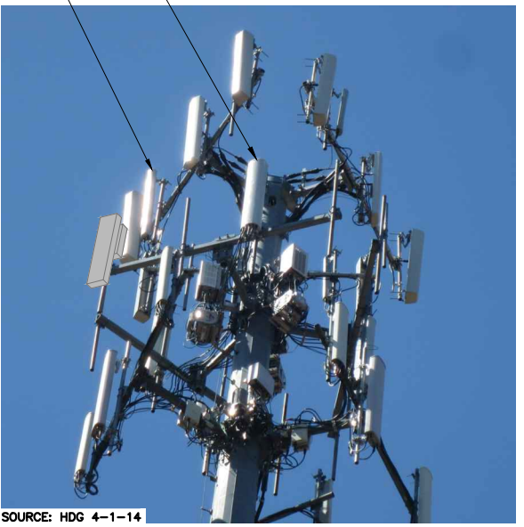
EXISTING PARTIAL ELEVATION PHOTO DETAIL SCALE: N.T.S.
