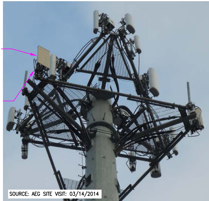
1 EXISTING ANTENNA MOUNT TYP. A-3 N.T.S.
