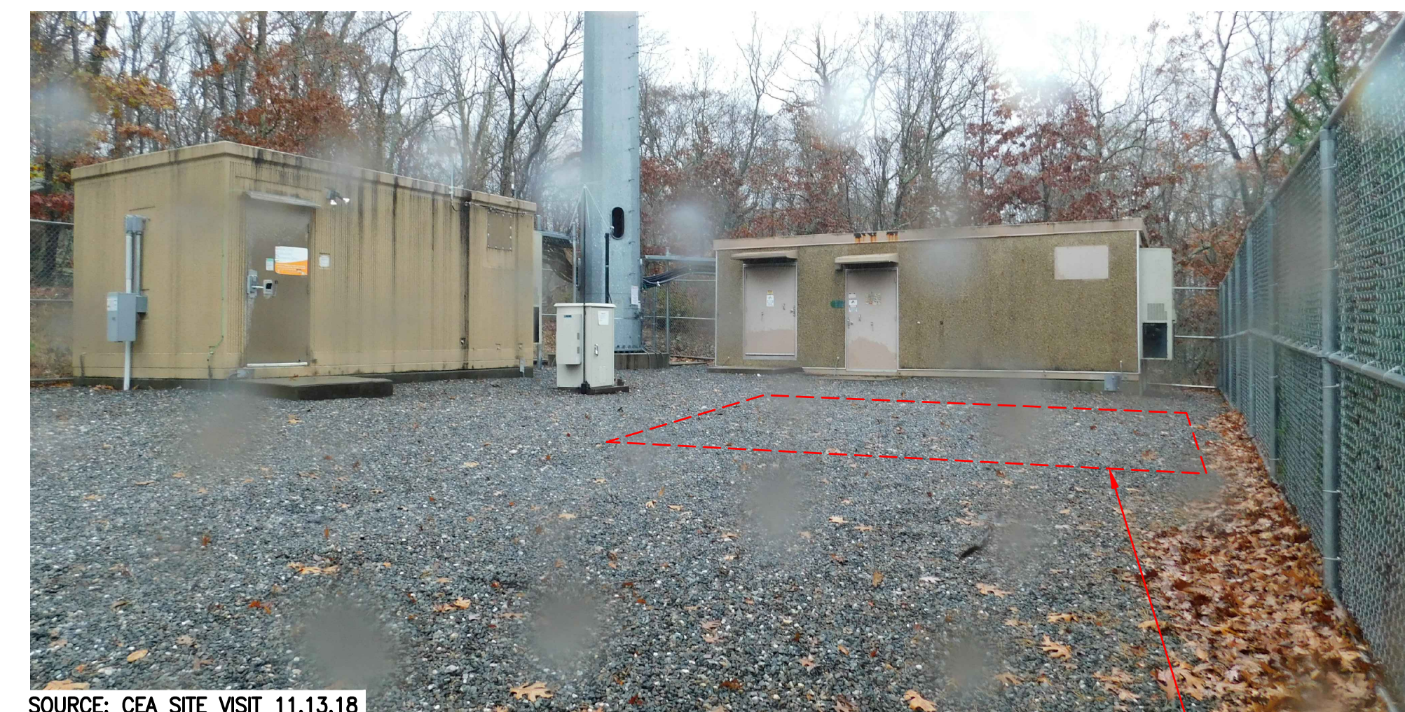
EQUIPMENT AREA PHOTO SCALE: N.T.S.
