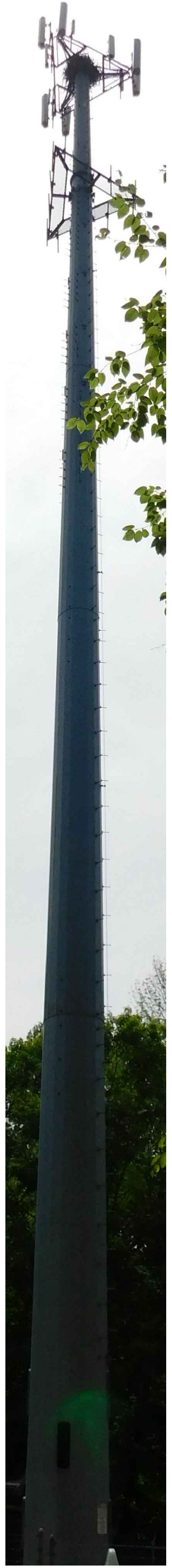
EXISTING TOWER PHOTO SCALE: N.T.S.
