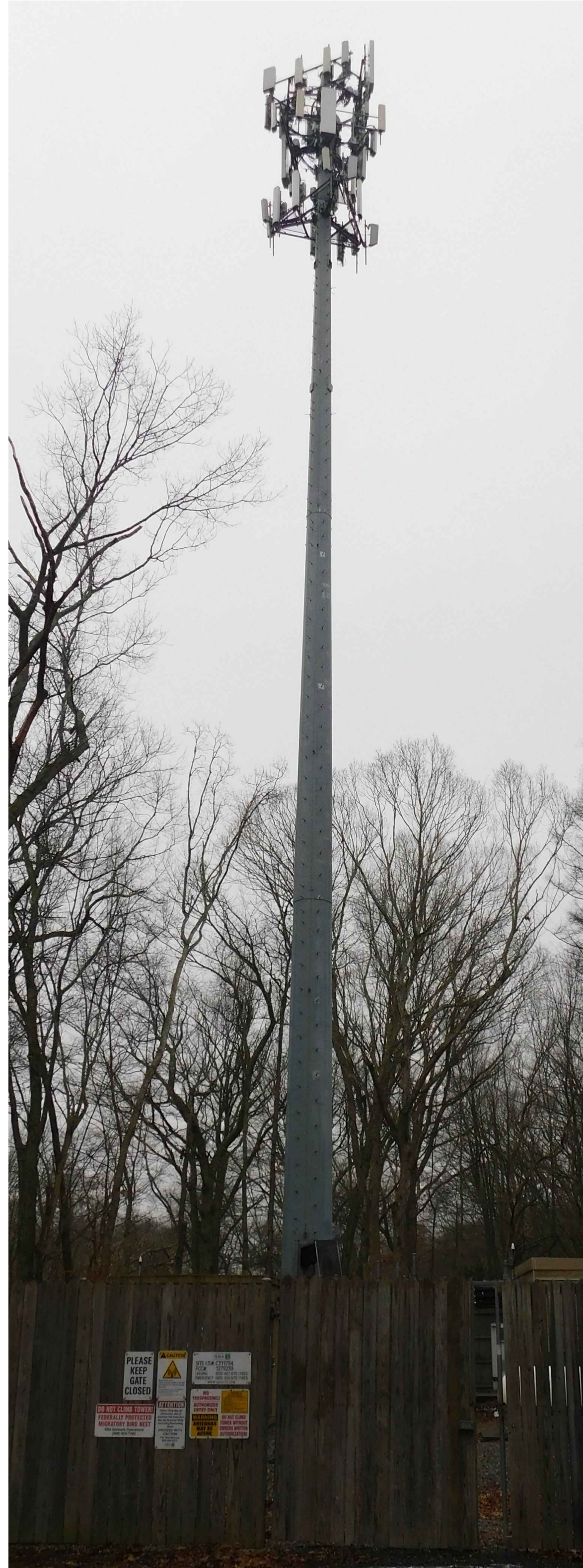
EXISTING TOWER PHOTO SCALE: N.T.S.
