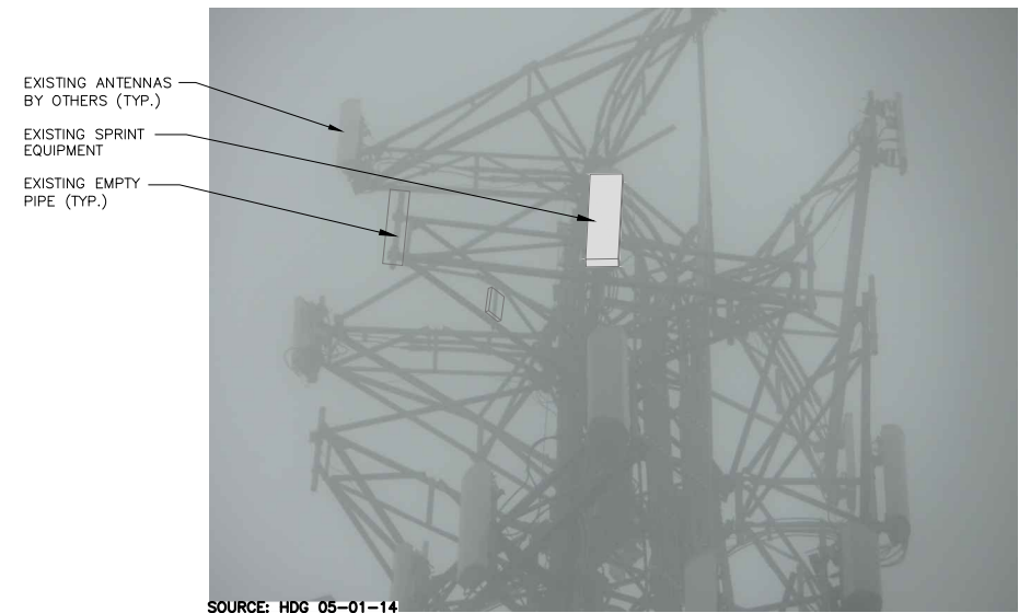
EXISTING PARTIAL ELEVATION PHOTO DETAIL SCALE: N.T.S.
