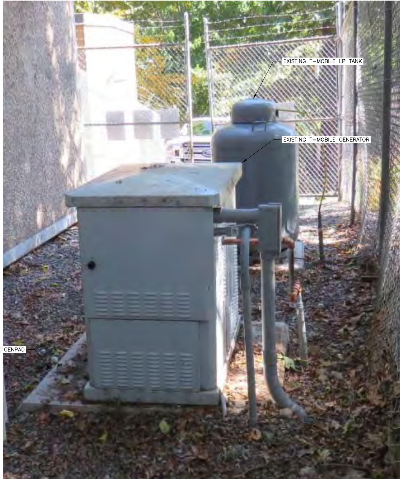
1 GENERATOR PHOTO SCALE: N.T.S.
