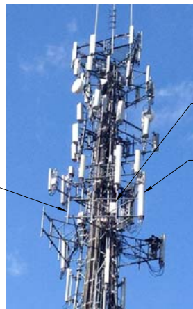
EXISTING PARTIAL ELEVATION PHOTO DETAIL SCALE: N.T.S.
