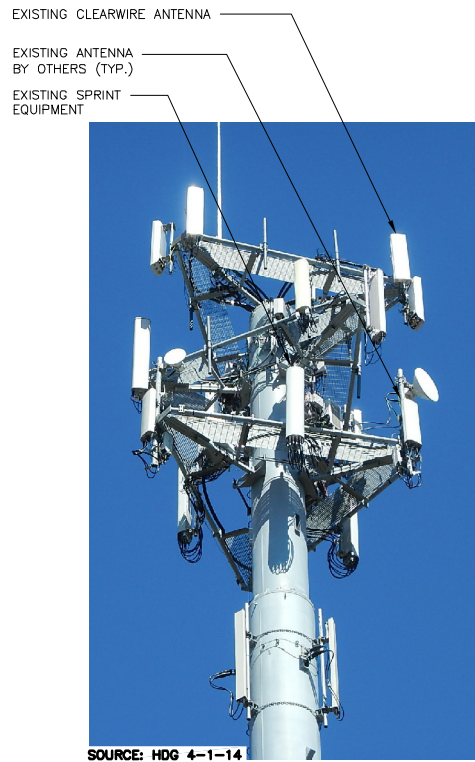
EXISTING PARTIAL ELEVATION PHOTO DETAIL SCALE: N.T.S.
