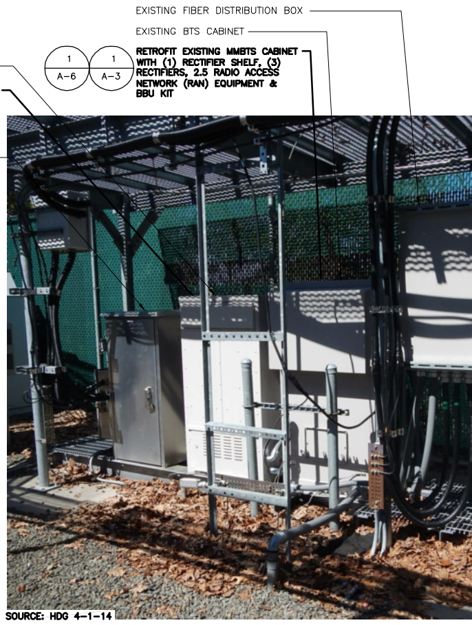
RAN EQUIPMENT PHOTO DETAIL 2 A-1 SCALE: N.T.S.
