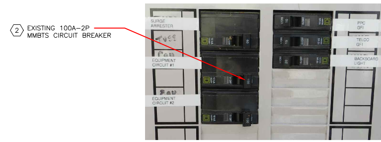
EXISTING PPC BREAKER PANEL SCALE: N.T.S.
